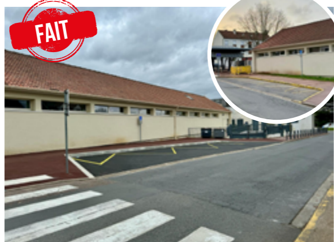
Aménagement de l'arrêt de bus scolaire et réfection totale du trottoir, rue des Peupliers.
